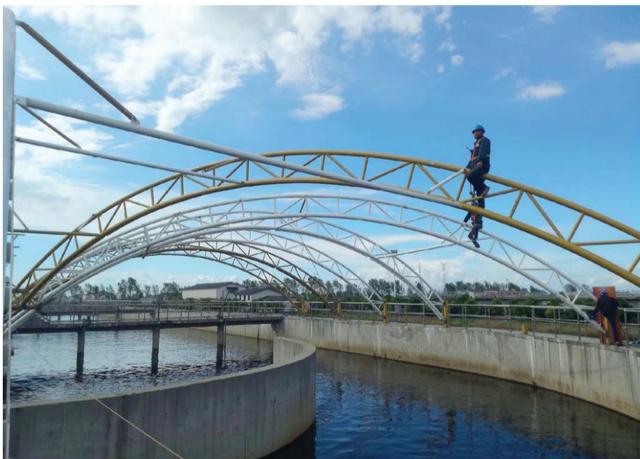
截至8月底，江滨水处理公司调节池4套生物除臭装置完成架子安装，电缆、风管、风机、水泵等配件全部进场，累计完成总工程量的70%，预计到9月底可完成膜加盖密封并投运。届时，江滨水处理公司除臭面积将扩大到近2万平方，基本实现中高浓度臭气全收集、全治理。图为施工人员正在安装钢架支撑杆。
