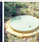
窨井安装"四道安全防坠装置",即:标识牌、防坠网、 自主研发的旋入式防坠装置、铸铁井盖
